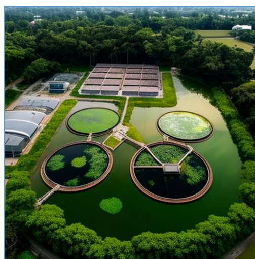
ภาพ โรงงานบำบัดน้ำเสีย
