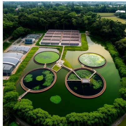
ภาพ โรงงานบำบัดน้ำเสีย(ที่มา:Alisa AI)
