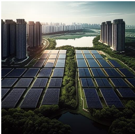
ภาพ Floating Solar Farms
